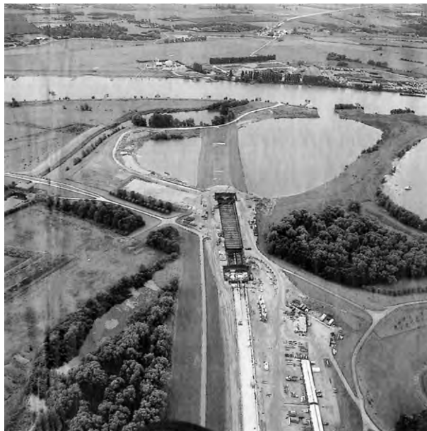
foto 4 Treintunnel in aanleg
